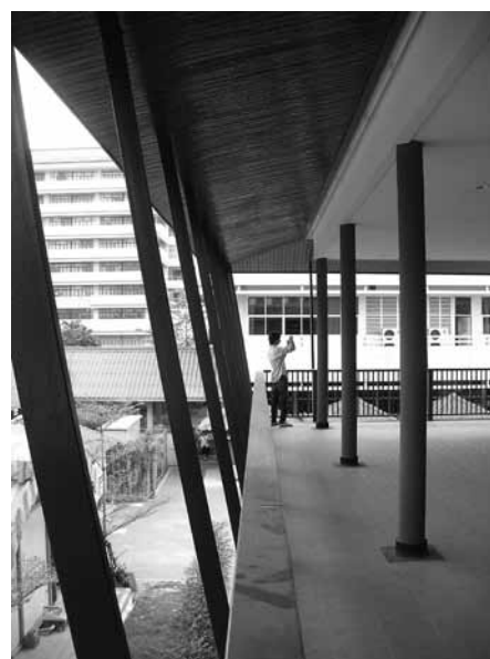
รูปที่ 13 การยื่นชายคาป้องกันรังสีอาทิตย์บริเวณพื้นที่รับประทานอาคารภายนอก ชั้นสอง
