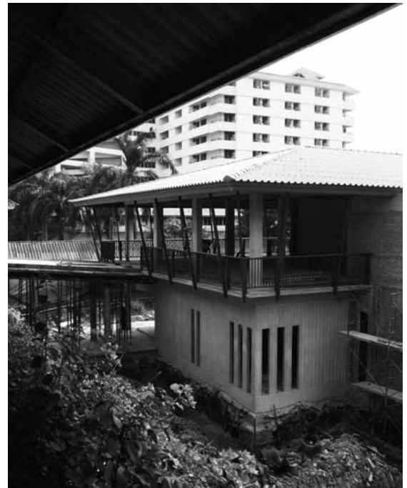
รูปที่ 16 ชายคายื่นระยะ 2.60 เมตร มีค้ำยันเป็นส่วนหนึ่งของโครงสร้างหลังคา และเป็นองค์ประกอบทางสถาปัตยกรรม
