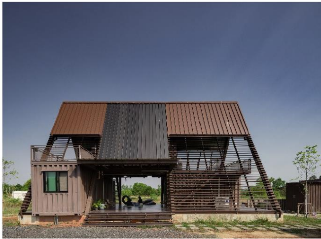
รูปที่ 11 การผสมผสานของโครงสร้างเหล็กแบบ A Frame และ หลังคาจั่วแบบลดระดับ
