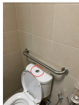
ที่ปล่อยน้ำเป็นชนิดปุ่มกดจากด้านหลัง
