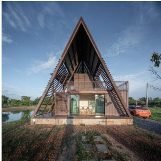
รูปที่ 7 โครงสร้างหลังคาหลักแบบ A Frame และ ส่วนของระเบียงหลักกลางบ้าน พร้อมระแนงกันแดด
