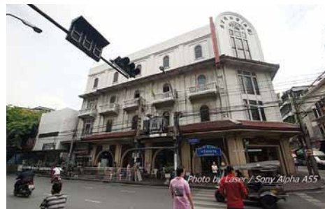
รูปที่ 1 อาคารในยุคที่ 2 ที่ถูกรื้อถอน
