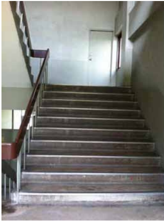
รูปที่ 3 บริเวณบันได อาคาร A7
