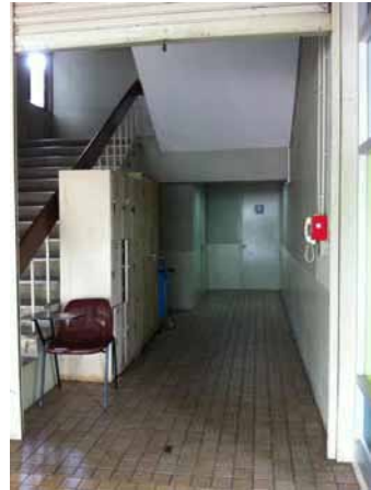
รูปที่ 5 บริเวณทางเดินชั้นล่าง อาคาร A7
