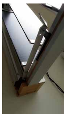
รูปที่ 5 การติดตั้งเซอร์โวมอเตอร์กับก้านโยกเปิด-ปิดของแผงกันแดด
