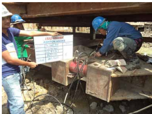
รูปที่ 15 การอัดแรง (Pre Load) เข้า Bracing
