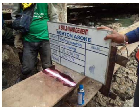
รูปที่ 17 การตรวจสอบรอยเชื่อม
