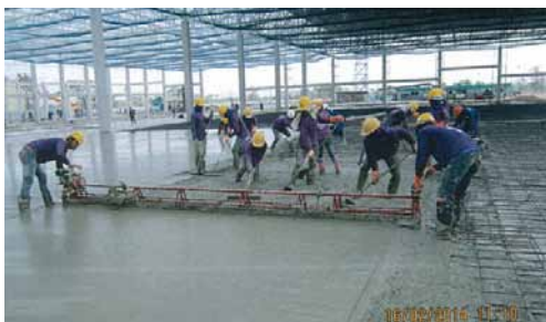
รูปที่ 5 การหล่อพื้นคอนกรีต
