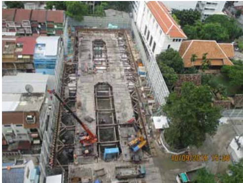
รูปที่ 2 อาคารข้างเคียงโครงการ Ashton Asoke
