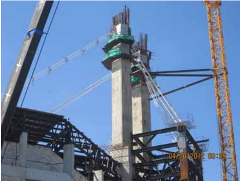
รูปที่ 10 การติดตั้งโดยใช้เหล็กรับแรงดึง
