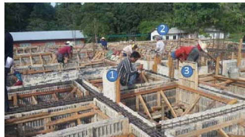
รูปที่ 5 การจำแนกลักษณะการทำงานของคนงานชุดเข้าแบบข้างคาน ยึดแบบข้างคานด้วยวิธีเสาค้ำยัน
