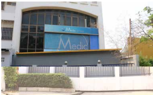
รูปที่ 3 อาคารกรณีศึกษาที่ 3 อาคารชั้นเดียวซึ่งต่อเติมจากอาคารเดิม โดยใช้แผ่นฉนวนโครงสร้าง เป็นผนังรับน้ำหนัก
