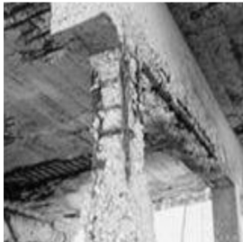
รูปที่ 3 โครงสร้างเสื่อมสภาพเนื่องจากการแยกตัว (สมนึก ตังเด็มสิริกุล, 2551)
